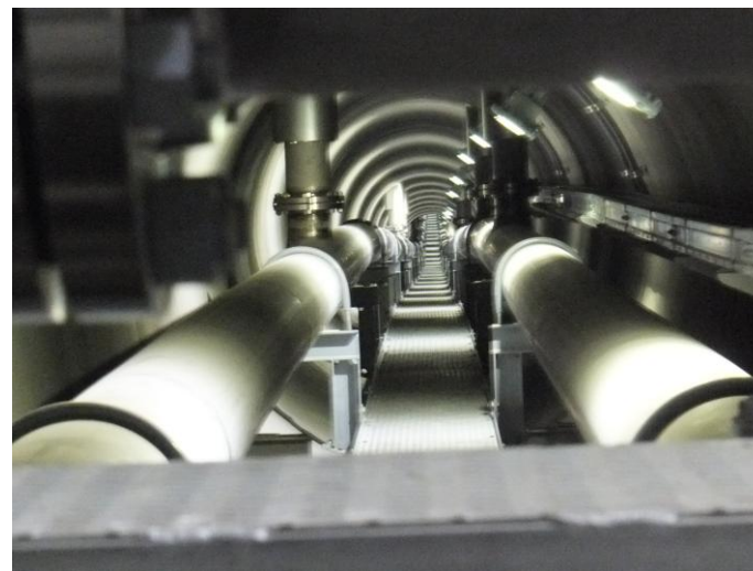
シールドトンネルの中に設置された ステンレス製燃料配管とLED照明
